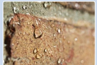
Lösen Mörtel, Staub und Schmutz mit einer Fassadenbürste entfernen. StormDry kann mit einer Rolle oder einem Pinsel aufgetragen werden. Aufgrund der thixotropen Einstellung ist die Gefahr von Verschmutzung an Fenstern und Türen minimal.
